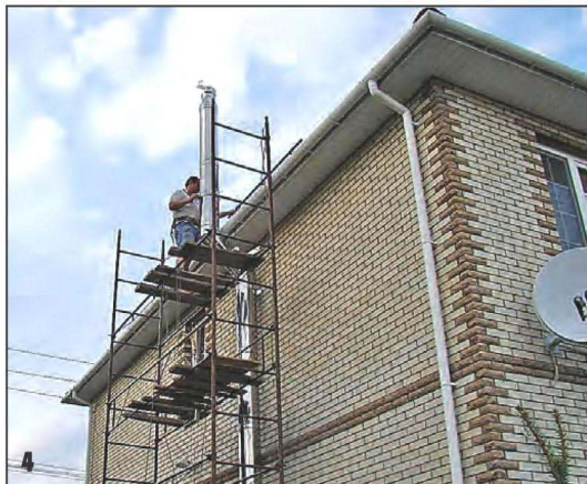
Чтобы свес крыши не прорезать, его пришлось обойти.
