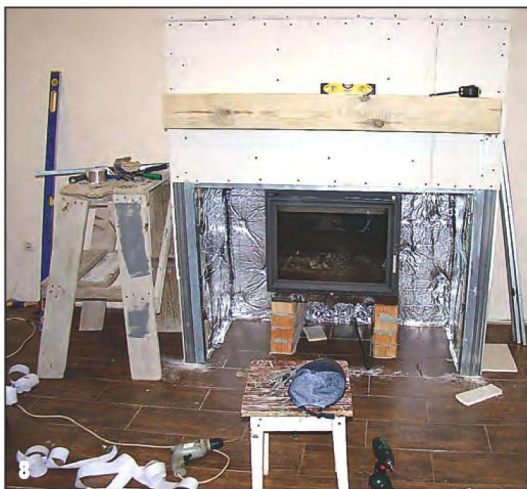
Снаружи каркас обшит гипсокартоном.
