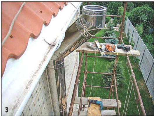
Чтобы свес крыши не прорезать, его пришлось обойти.
