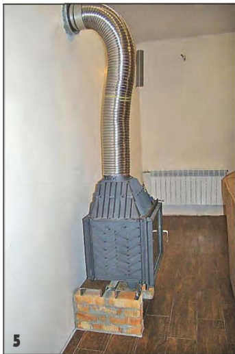
Чугунная вставка установлена и подключена к дымоходу.
