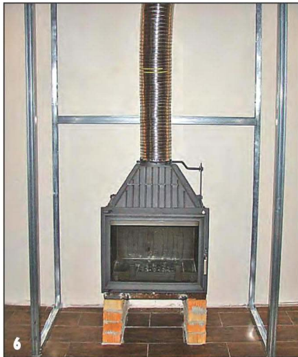
Каркас портала камина собрали из металлических профилей.
