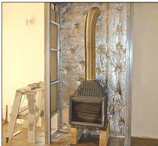
Изнутри каркас обложен фольгированными плитами Firerock.
