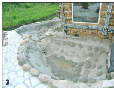
Защитный верхний слой бетона армируем стальной сеткой.
