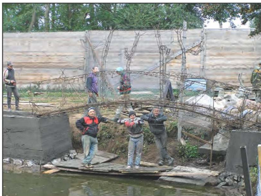
Сооружение каркаса будущего моста.
