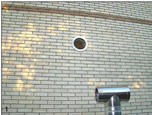
Чтобы вывести дымоход на улицу, в стене пробили отверстие.
