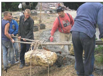
Подготовка котлована и формирование стен будущего водоёма.
