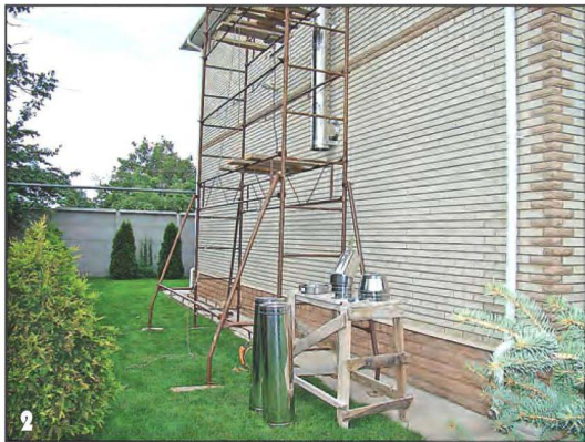
Металлический дымоход вели снаружи здания на небольшом расстоянии от стены.
