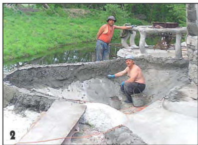
Укладка бетона в чашу будущего водоёма.
